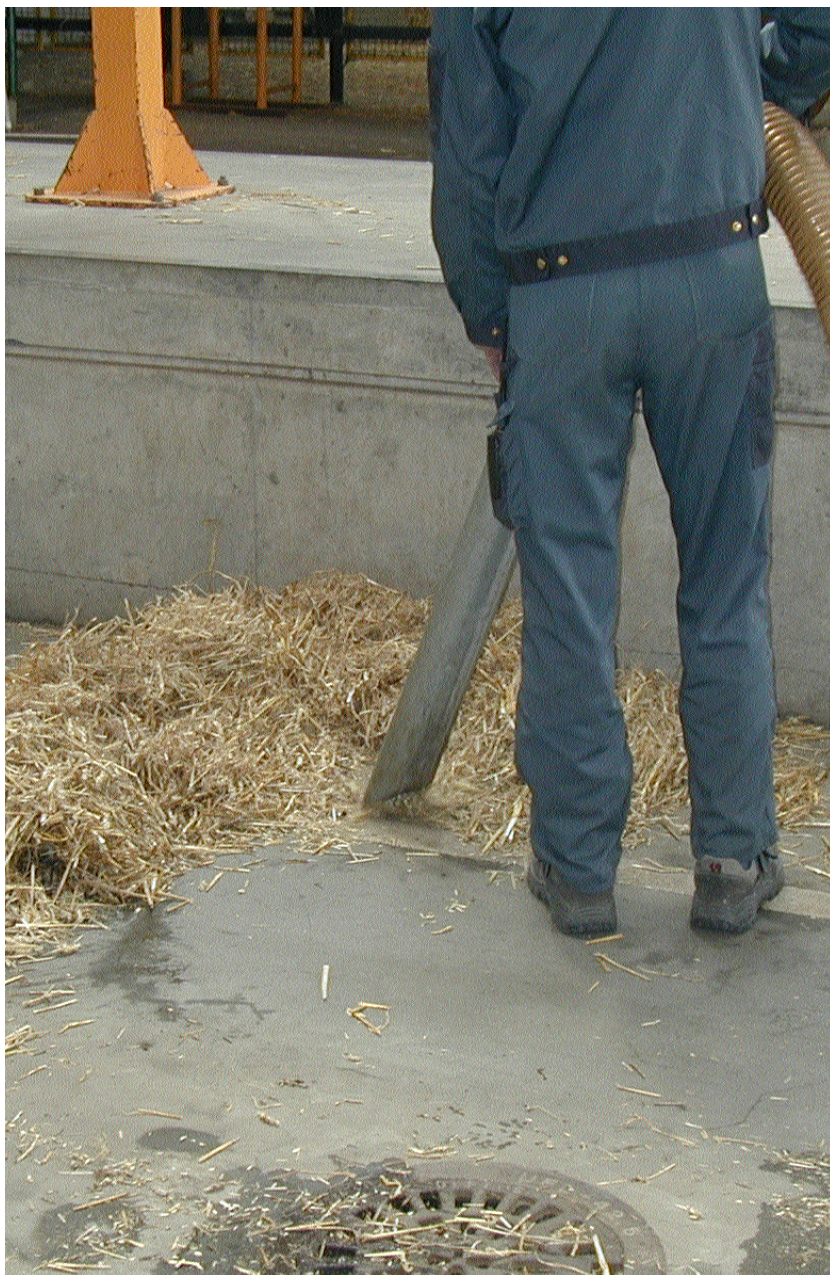
Halmspild efter aflæsning af halm fjernes effektivt af et centralt støvsugeranlæg.
