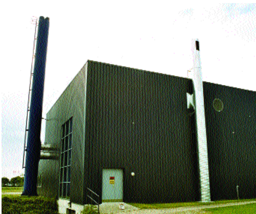
Indsugningsskorsten til friskluftindtag.
