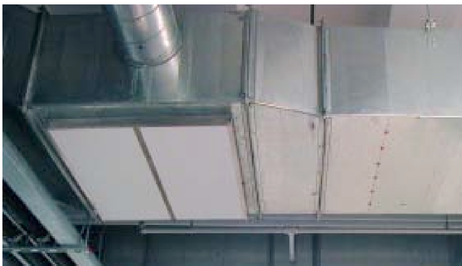
Absorbenter monteret direkte under ventilationskanalen.
