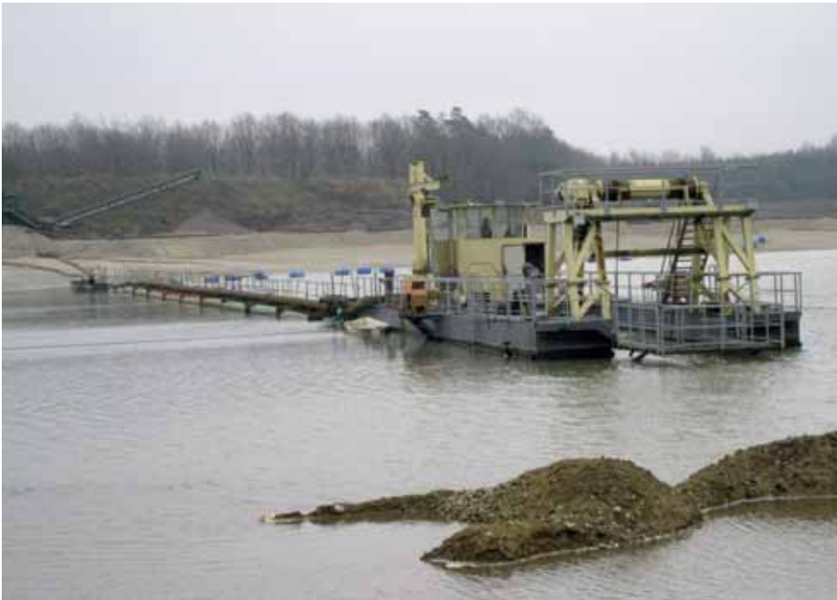
Vådgravning og vådsugning.
