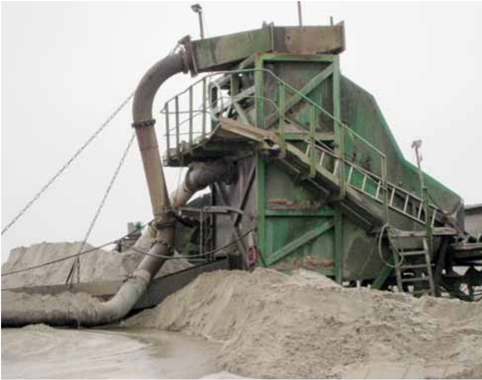
Platform forsynes med rækværk mod ulykkesfare.
